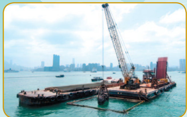
海底疏浚工程 Dredging of sea-bed
